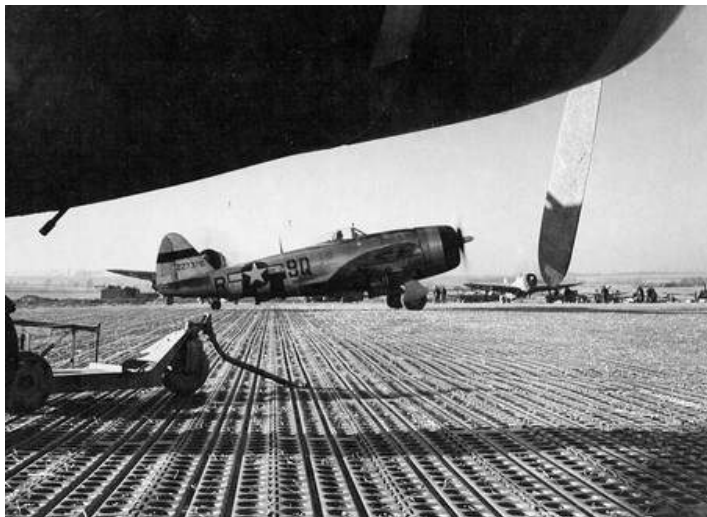
Un P-47 sur les plaques perforées d'un Advanced Landing Ground posées par les équipes du génie.
