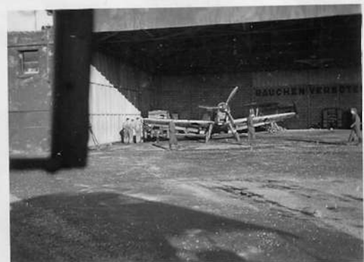
Me Bf 109 E en réparation. Au fond du hangar est inscrit « Rauchen verboten » (interdit de fumer).
